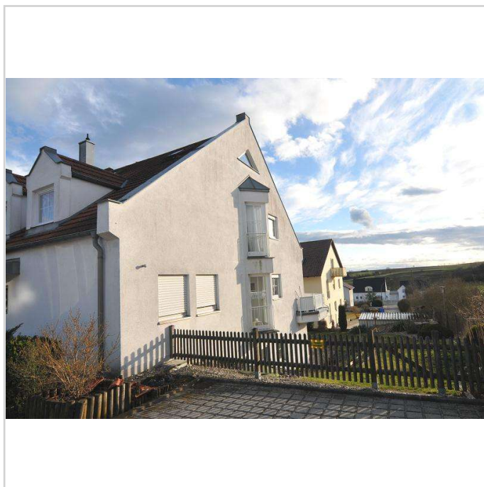
Haus von Außen
